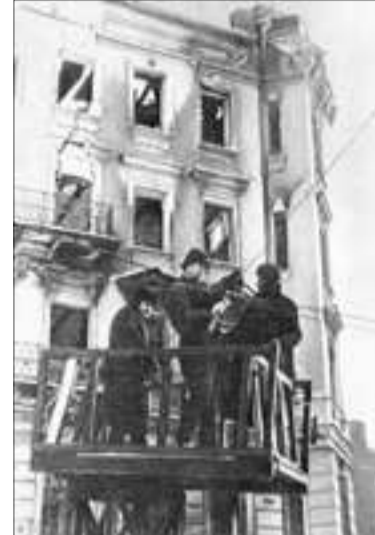
Бригада монтеров восстанавливает контактную сеть. 1942 г.
