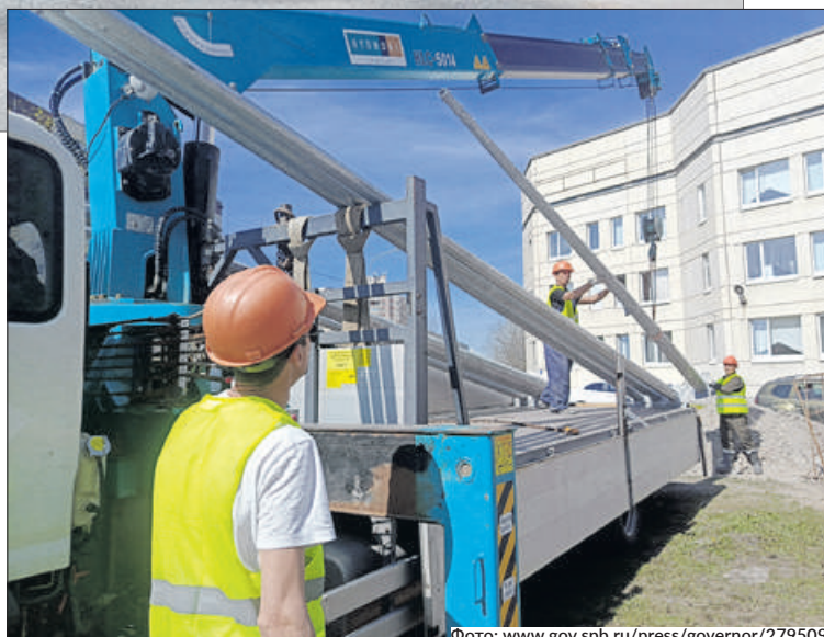
Новое световое оборудование будет установлено в квартале, в границах которого проживают около 10 тысяч жителей Невского района, размещены социальные объекты.
