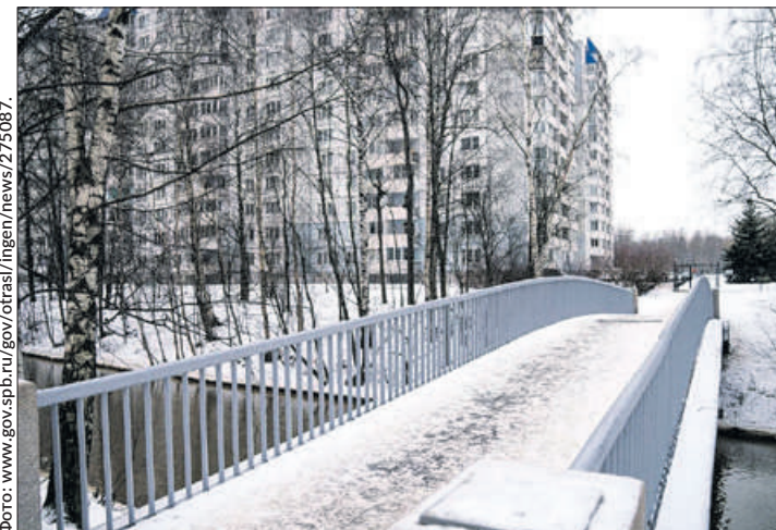
Важнейшим этапом проекта стала замена защитного короба и укладка новых трубопроводов под пешеходным мостом через реку Оккервиль.
