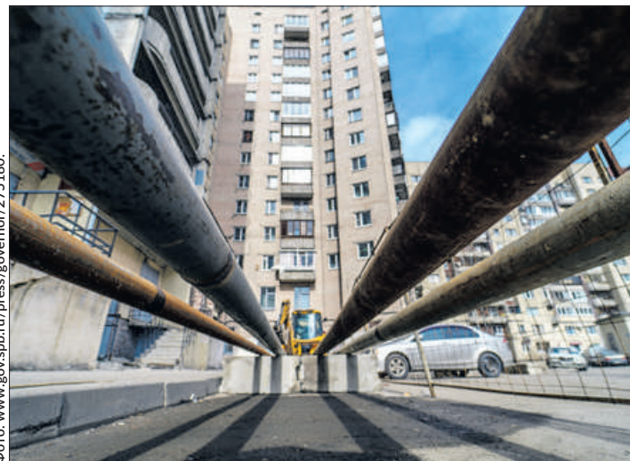
Новые трубы провели к 10 зданиям, в том числе к 9 жилым домам и к школе №268.
