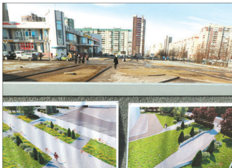
Работы по благоустройству территории около станции метро «Проспект Большевиков» должны завершиться уже в этом году.
