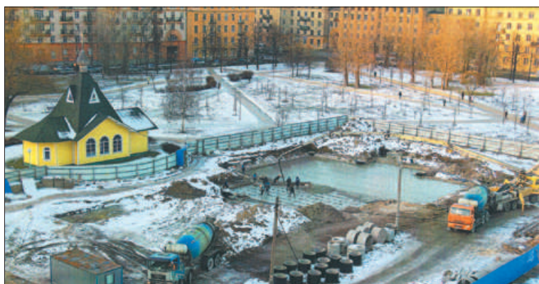
Сейчас вокруг места разрушенного храма разбита строительная площадка.
