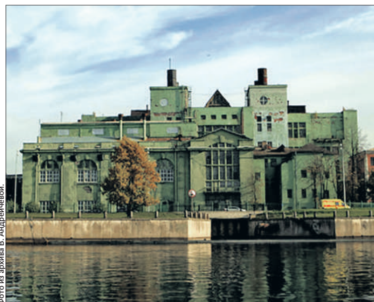
Вид бывшей 5-й ГЭС «Красный Октябрь» со стороны Невы, 1933 г.
